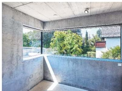
Anders als bei mehrschichtigen Wandaufbauten können mit Infralichtbeton einfache und robuste Konstruktionen realisiert werden.
