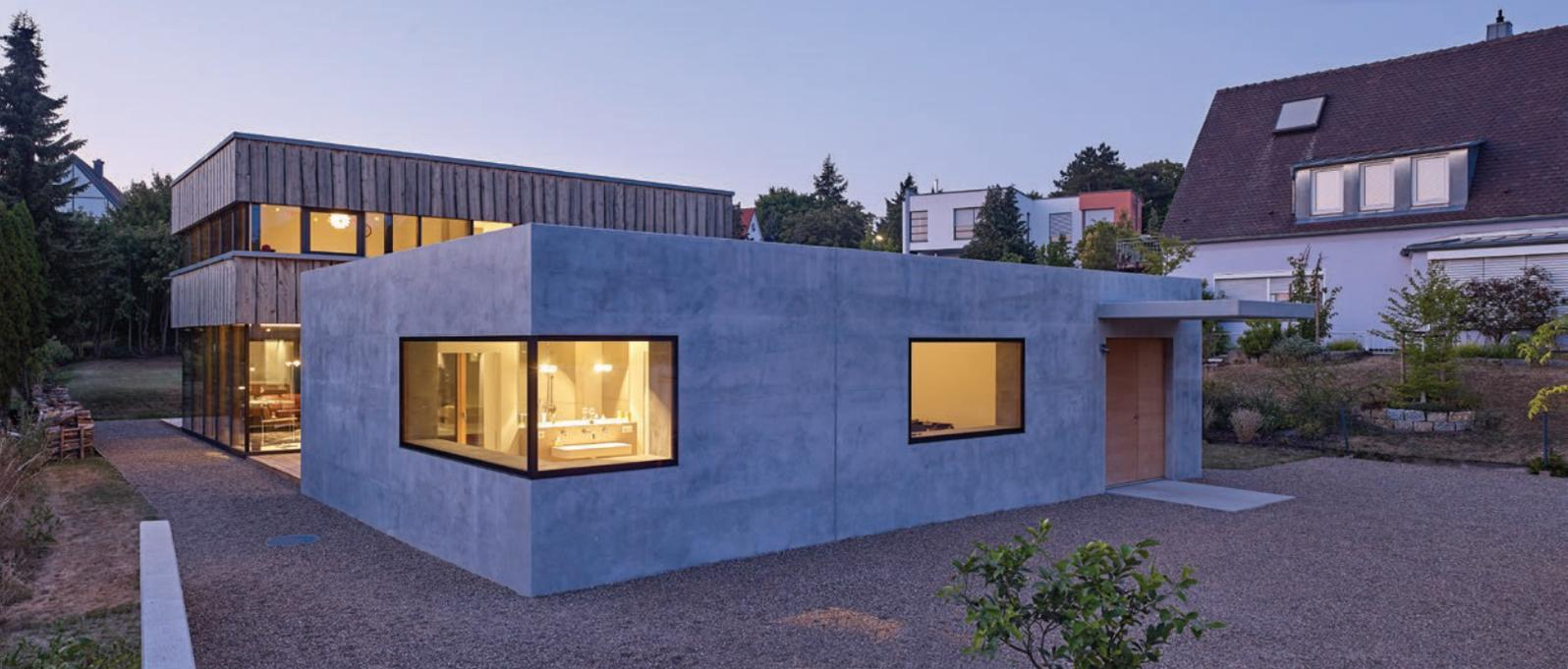
Die 45 cm starken Außenwände des straßenseitigen Gebäudeteils bestehen aus Infraleichtbeton.
