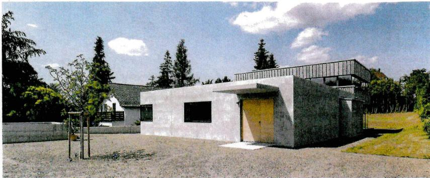
Die 45 Zentimeter starken Außenwände des straßenseitigen Gebäudeteils bestehen aus Infraleichtbeton. Abb.: InformationsZentrum Beton/Guido Erbring
